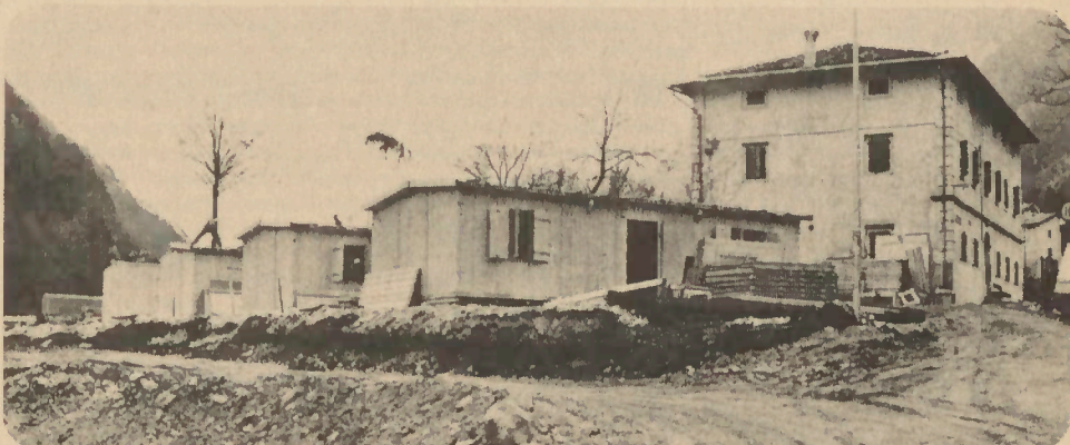
Teilansicht der entstehenden Merkur-Siedlung auf einem Gemeindegrundstück von Resiutta
