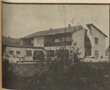
Das neue Rotkreuzzentrum Altötting
