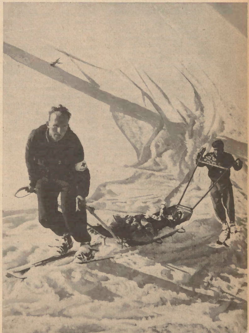
Abtransport eines Verletzten mit dem Akia, dem von der Bergwacht entwickelten Rettungsgerät, von dem sie bisher 127 (im letzten Jahre 37) im Werte von 31 700 DM in eigenen Werkstätten herstellte.
